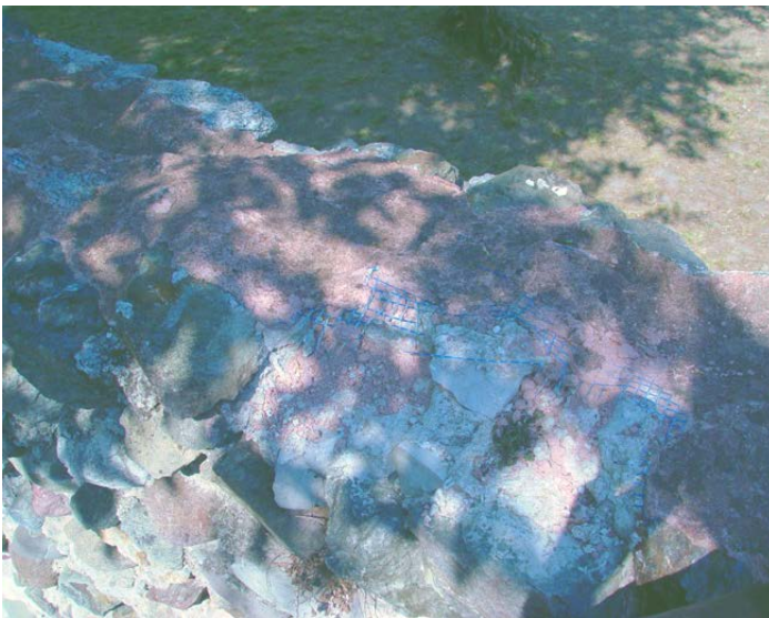
Figura 44. Puegnago del Garda, Brescia, stato di conservazione della copertina in cocciopesto dopo cinque anni dalla stesura (foto B. Scala).
