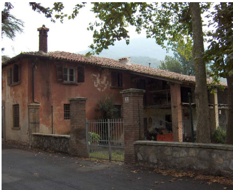
Figura 12. Rodengo Saiano, Brescia, cascina. La struttura costituisce la parte rustica di una casa signorile. La qualità dell'architettura emerge anche dal camino più prossimo alla strada che mostra fattezze inusuali per l'edilizia rustica. Interessante è la presenza del porticato coperto dall'aggetto della falda del corpo principale (foto B. Scala).
