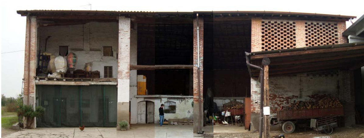
Figura 15. Cascina nella Bassa Bresciana con gelosie nel fienile. Gli edifici, organizzati attorno a una corte, sono a due piani e realizzati completamente in mattoni. Generalmente i portici a doppia altezza fronteggiavano i locali delle stalle sopra le quali erano collocati i fienili (foto B. Scala).
