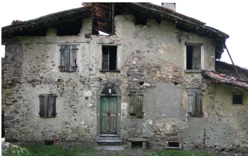
Figura 3. Pisogne, Brescia, casa Minico Staffoni. Il materiale costruttivo è la pietra (scisti o graniti) cavata nelle vicinanze. Essa veniva sbazzata e messa in opera realizzando murature di notevole spessore che, fra l'altro, garantivano un buon isolamento termico all'interno. Interessante notare come, conformemente alla buona pratica del costruire, sugli angoli si trovino elementi di maggior dimensione, mentre la restante parte della muratura è costruita con blocchi più piccoli (foto B. Scala).
