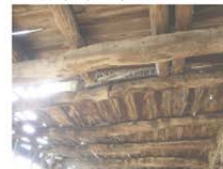
Particolare del cambio di direzione dell'orditura.
