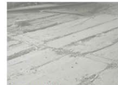
Particolare del battuto del solaio del porticato.
