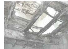
Particolare del solaio di un ambiente interno a doppia orditura.
