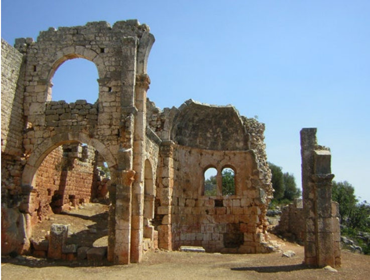
Figura 8. Kanytelleis. Veduta della basilica A; le architetture allo stato di rudere dell'intero borgo abbandonato risalgono principalmente all'età pagana e a quella bizantina, ma non mancano esempi di architetture islamiche (foto E. Romeo, 2005).
