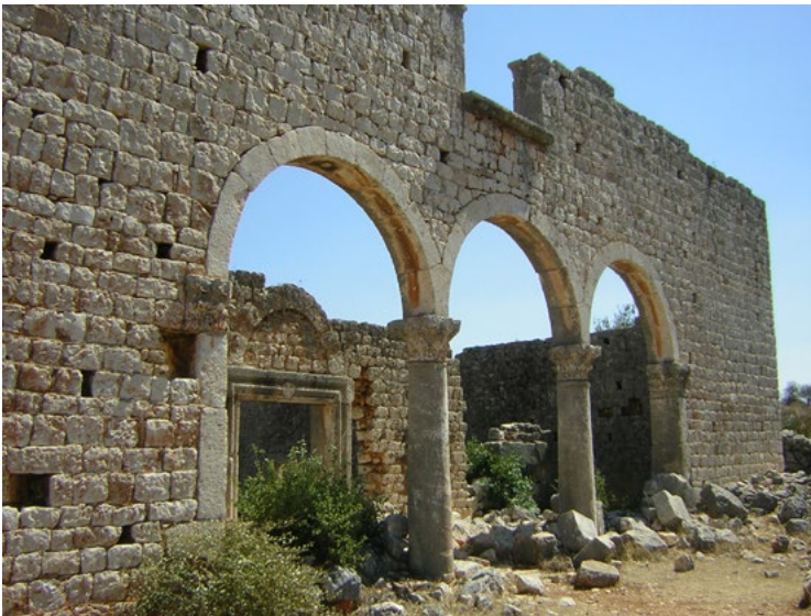
Figura 9. Kanytelleis. Veduta della basilica D; tutti gli edifici mostrano interessanti esempi di dissesto strutturale o di crolli primari ancora ben conservati (foto E. Romeo, 2005).
