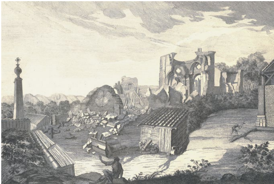
Figura 8. Ignazio Stile, Antonio Zaballi, Chiesa de' Basiliani in Seminara ruinata mentre portione della medesima si restaurava (da ZINZI 1990, tav. LV, p. 155).
