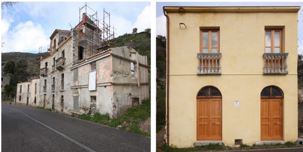
Figura 4. Gairo Vecchio (Nuoro). Recupero di due fabbricati siti nel centro storico nell'ambito della programmazione POR FESR - 2007-2013, il bando CIVIS (foto M. Porcu, 2018).
