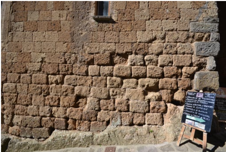
Figura 6. Civita di Bagnoregio. CA n. 5, CF1, paramento esterno est (foto I. Zamboni, 2017).
