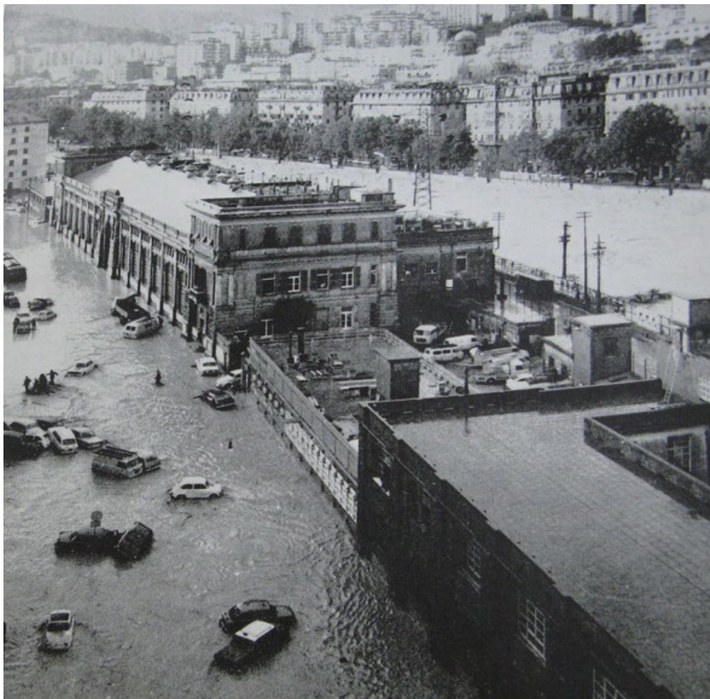
Figura 1. Genova, il torrente Bisagno nella zona di via Canevari durante l'alluvione dell'ottobre 1970, si vede l'edificio della centrale elettrica (1896) invaso dall'acqua (da FERRANDO, FERRANDO 1970, p. 56).
