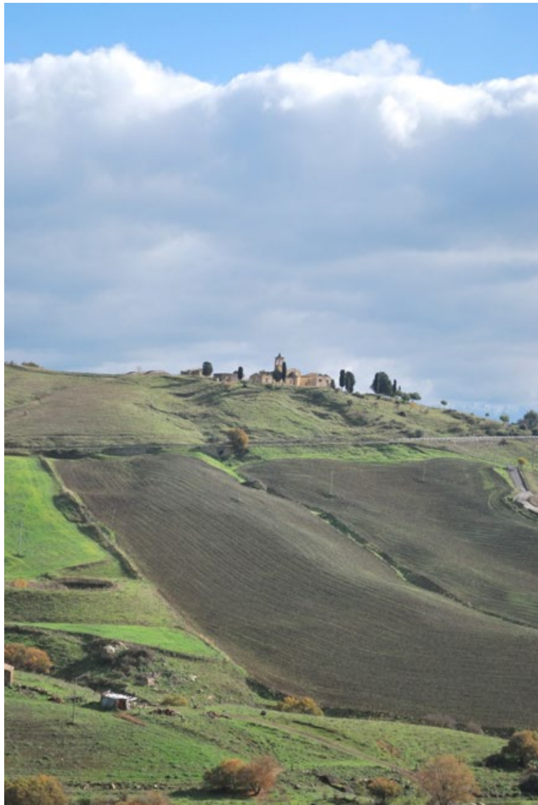
Figura 11. Borgo Salvatore Giuliano, Cesarò (Messina). Veduta generale del borgo e del paesaggio circostante (foto A. De Luca, 2015).
