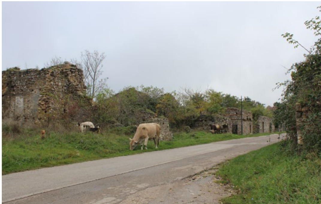
Figura 7. Carbonara- Aquilonia (Avellino). Vista dei ruderi dell'antico insediamento urbano (foto R. Amore, 2018).
