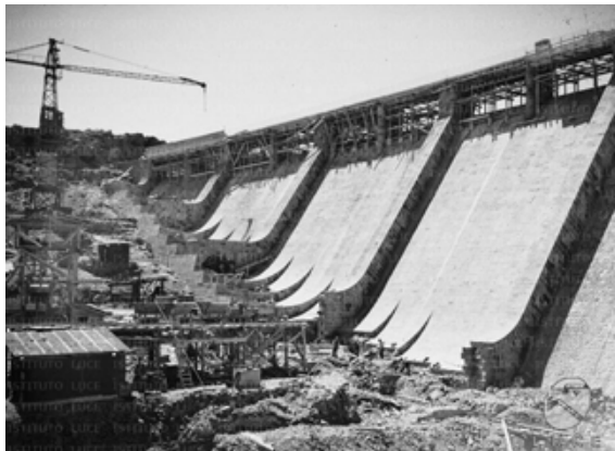
Figura 6. Il cantiere di costruzione della diga di Monte Pranu nei pressi della borgata di Palmas (Archivio dell'Istituto Luce).
