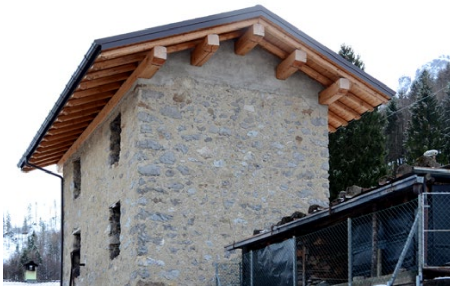
Figura 9. Valtorta (Bergamo). Intervento di sostituzione della copertura (foto B. Silva, 2018).
