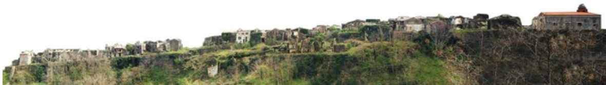
Figura 8. Tocco Caudio (Benevento). Vista del versante occidentale dell'abitato. Si riconosce una parte del muro di consolidamento realizzato nel secondo decennio del Novecento (foto L. Romano, 2014).
