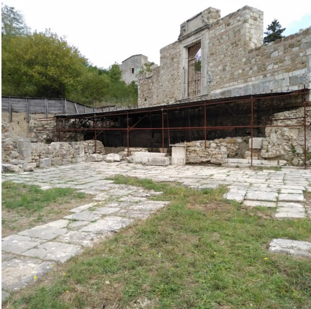
Figura 11. Particolare del foro dell'antica Compsa con la i resti della Cattedrale distrutta dal sisma del 1980 (foto B.G. Marino, 2018).
