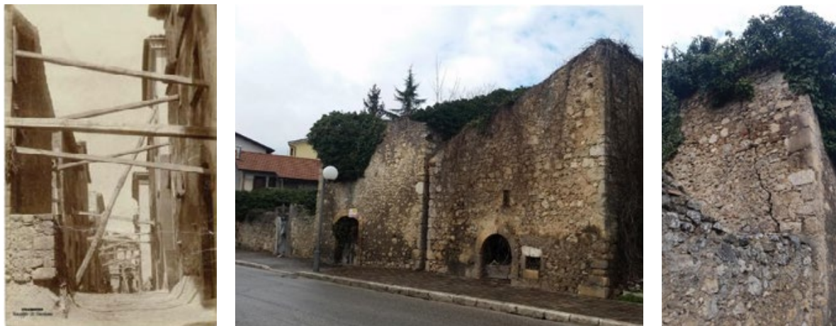
Figura 11. Magliano dei Marsi (L'Aquila). L'immagine storica a sinistra mostra le facciate di edifici presidiate, dopo il sisma del 1904, con grosse travi lignee poste in opera per contrastare possibili ribaltamenti delle pareti su strada (dalla Collezione Giuseppe di Girolamo pubblicata online: http://www.gvmprotezionecivile.it/memoria-sismica-magliano-dei-marsi/terremoti-storici-locali/terremoto-magliano-1904 , ultimo accesso novembre 2018). Le altre immagini mostrano alcuni immobili tuttora esistenti, reduci dai terremoti novecenteschi della Marsica e lasciati in completo stato di abbandono; in particolare nell'immagine di destra si nota una lesione inclinata visibile su una parete ortogonale al muro di facciata, effetto di un incipiente ribaltamento del fronte su strada (foto A. Donatelli, 2018).
