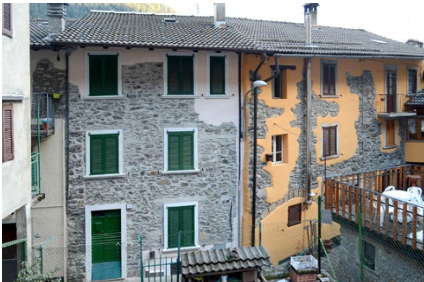
In alto, figura 11. Fortunago (Pavia). Totale scrape degli intonaci (foto B. Silva, 2018); a sinistra, figura 12. Mezzoldo (Bergamo). Rinnovo parziale scrape degli intonaci (foto B. Silva, 2018).
