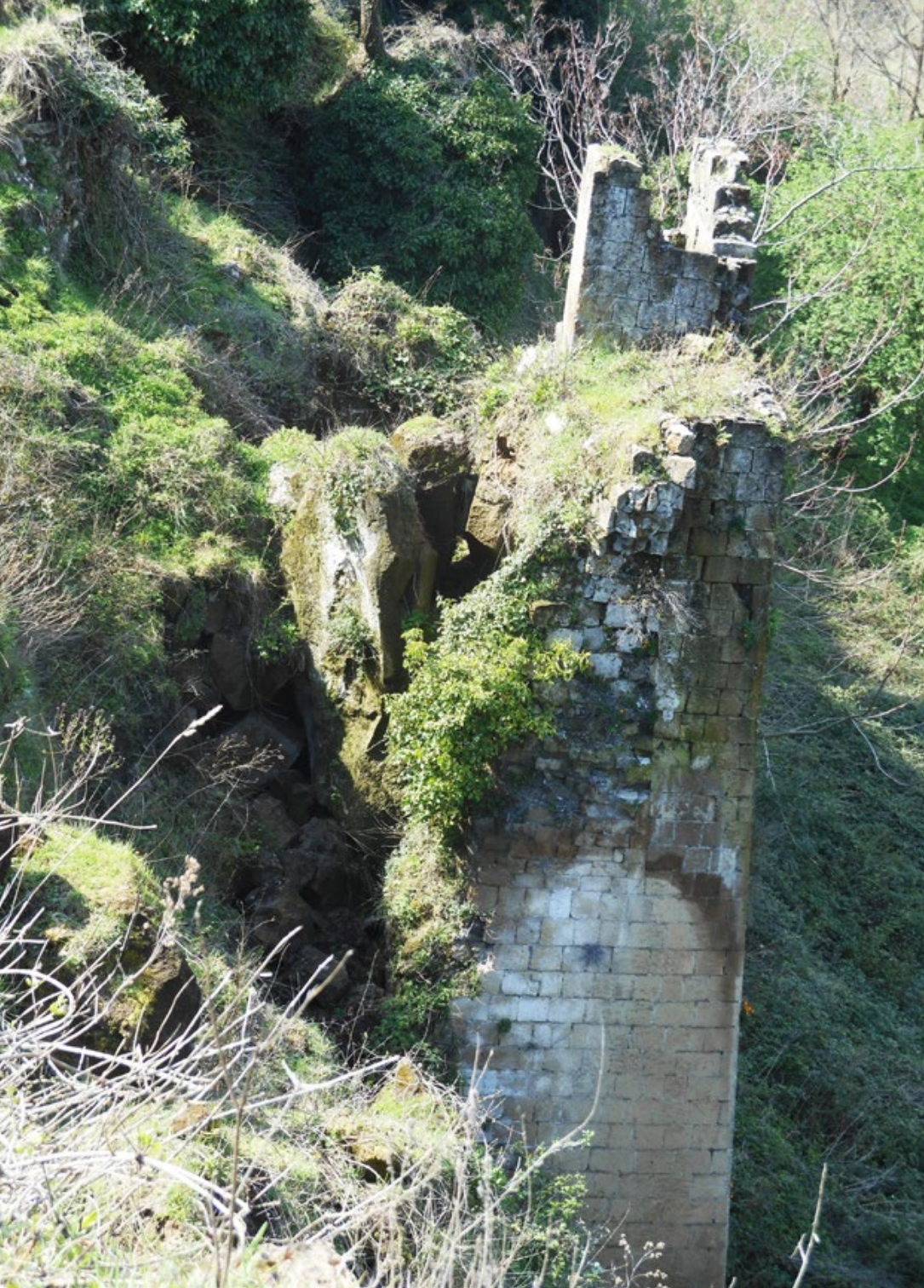
Figura 10. Tocco Caudio (Benevento). Versante occidentale dell'abitato. L'immagine mostra la struttura di contenimento in tufo deformata e parzialmente crollata a seguito degli smottamenti registrati a metà del Novecento (foto L. Romano, 2014).
