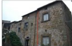
Prospetto esterno nord-est
