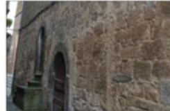
Prospetto esterno sud-ovest
