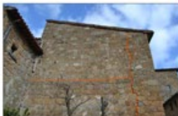
CF5 - Prospetto esterno sud-est
