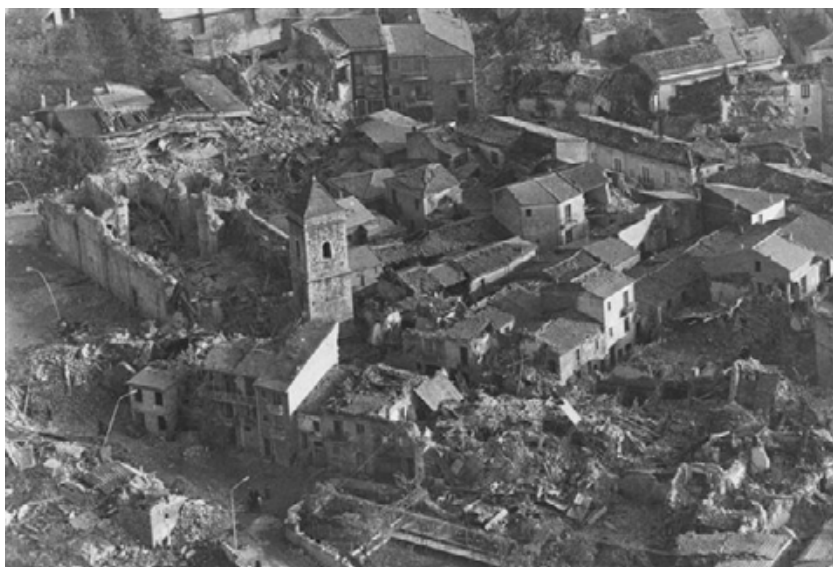
Figure 5-6. Due immagini dei danni del terremoto a Lioni (Avellino). In primo piano la chiesa di Santa Maria Assunta ( https://www.irpiniaoggi.it/wp-content/uploads/2019/11/sisma-lioni.jpg ; fig. 6 https://comunitaprovisoria.wordpress.com/2009/11/23/ventinove-anni-fa/ , ultimo accesso 5 maggio 2020).
