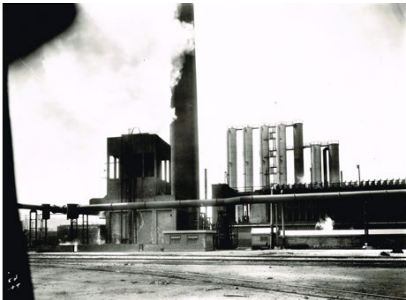
In alto, figura 8. La piana di Bagnoli con l'Ilva in una fotografia del 1949 (Napoli, Archivio Italsider Bagnoli); a sinistra, figura 9. La Cokeria dell'Ilva in una fotografia degli anni cinquanta del Novecento (Napoli, Archivio Italsider Bagnoli).
