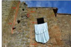
CF6 - Prospetto esterno sud-est
