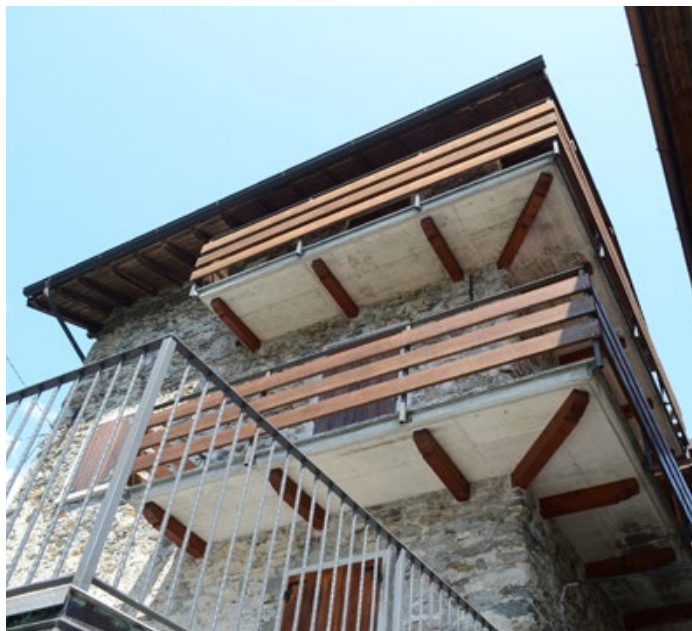
A sinistra, figura 13. Peglio (Como). Nuovi scale in calcestruzzo armato (foto B. Silva, 2018); a destra, figura 14. Livo (Como). Nuovi balconi con struttura mista legno-calcestruzzo armato (foto B. Silva, 2018).
