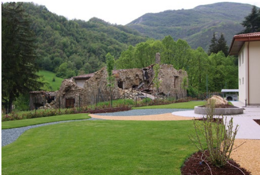
In alto, figura 7. Quartiere C.A.S.E. di Bazzano, L'Aquila (foto F. De Matteis, 2015); a sinistra, figura 8. Centro Agorà ad Arquata del Tronto (Ascoli Piceno) (foto F. De Matteis, 2018).
