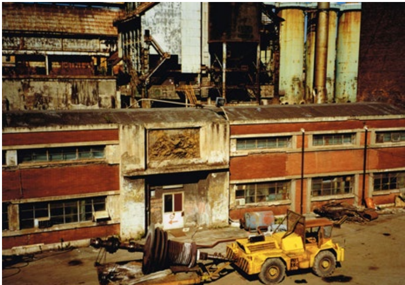
Figura 11. Il settore della Centrale Telefonica dell'Italsider di Bagnoli negli anni della dismissione, 1998 (foto S. Di Liello, 1998).
