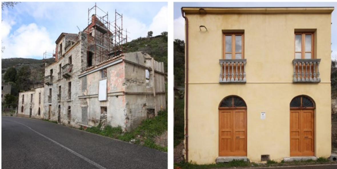
Figura 4. Gairo Vecchio (Nuoro). Recupero di due fabbricati siti nel centro storico nell'ambito della programmazione POR FESR - 2007-2013, il bando CIVIS (foto M. Porcu, 2018).
