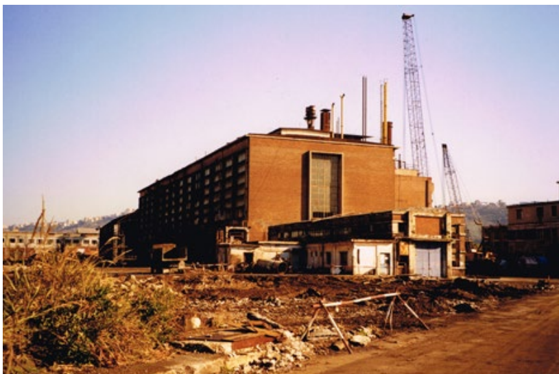
Figura 12. L'area dell'Officina Meccanica, 1998 (foto S. Di Liello, 1998).
