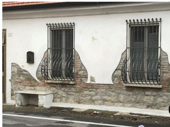
Figura 13. Aquilonia (Avellino). Alcuni degli edifici della città nuova sono stati parzialmente privati del rivestimento di intonaco per mettere a nudo la sottostante struttura muraria. E ciò nel tentativo di ricostruire una sorta di “legame costruttivo” tra la nuova città e i ruderi in pietra viva dei resti dell’antica Carbonara (foto R. Amore, 2019).
