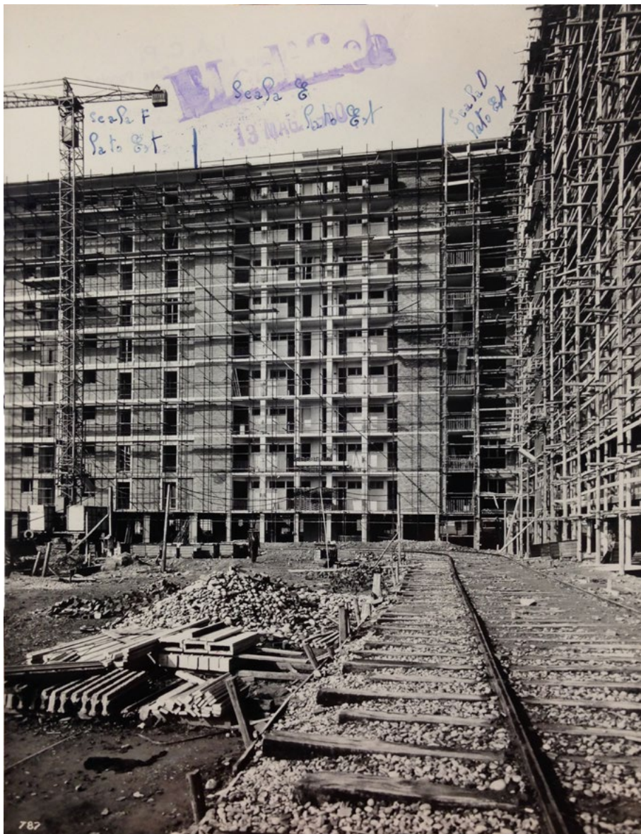
Figura 11. Fotografia della fase di cantiere dell'Edificio 16, scale D ed E Gruppo Mario Terzaghi, F Gruppo Giancarlo De Carlo, 13 maggio 1960. ACCMI, Cartella Quartiere Feltre, P.G. 171521, fotografia n. 787.
