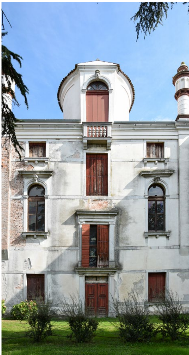
Figura 22. Canda (Rovigo). Villa Nani Mocenigo, veduta del fronte occidentale in cui insiste il corpo scale nella sua configurazione attuale (foto E. Montalti, 2019).
