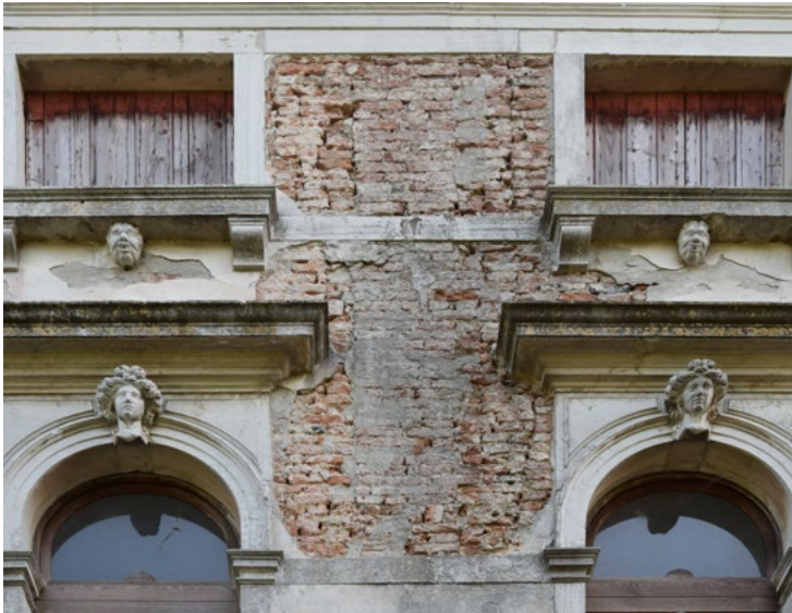
Figura 9. Canda (Rovigo). Villa Nani Mocenigo, fronte settentrionale, traccia di una preesistente canna fumaria esterna (foto E. Montalti, 2019).
