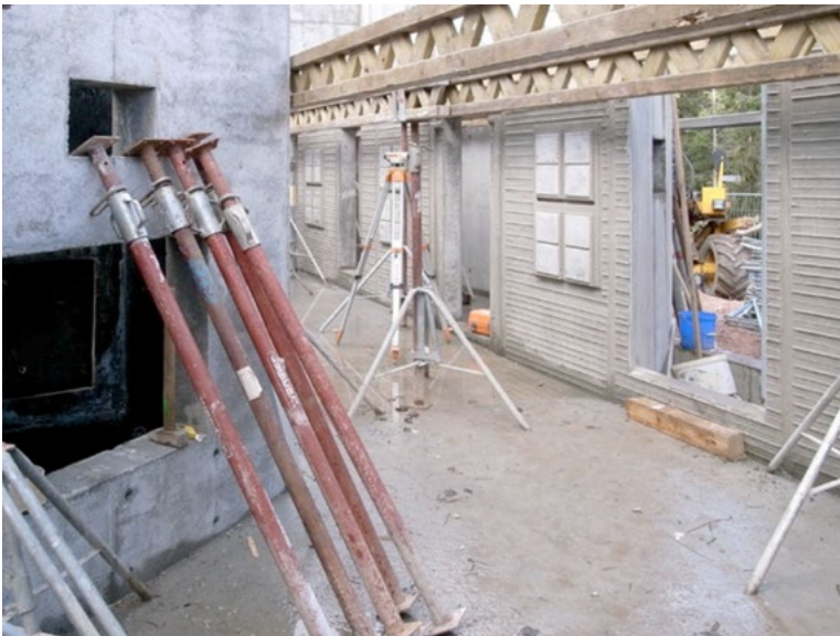
Figure 12-13. AFF, casa di vacanze, Tellerhäuser, 2009-2010, fotografie di cantiere. AAFB.
