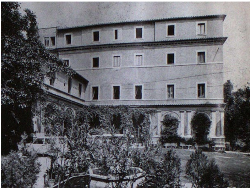
Figura 29. Veduta del casino di Villa Balbina (archivio privato).
