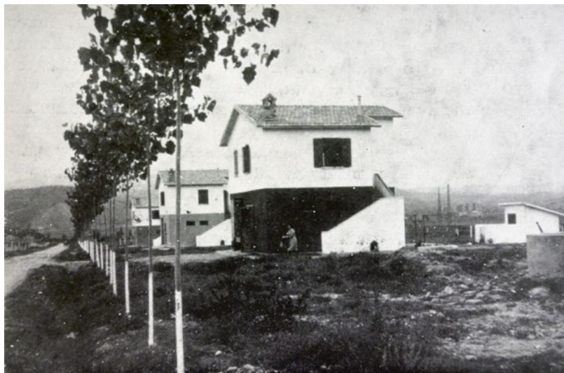
In alto, figura 2a-b. Il sistema insediativo di tipo sparso nella zona collinare e in quella pianeggiante del Marchesato di Crotona, anni Cinquanta; a sinistra, figura 3. La casa rurale di tipo "Cassano" nel Marchesato di Crotona, anni Cinquanta (da ROGLIANO 1962, pp. 45, 47).
