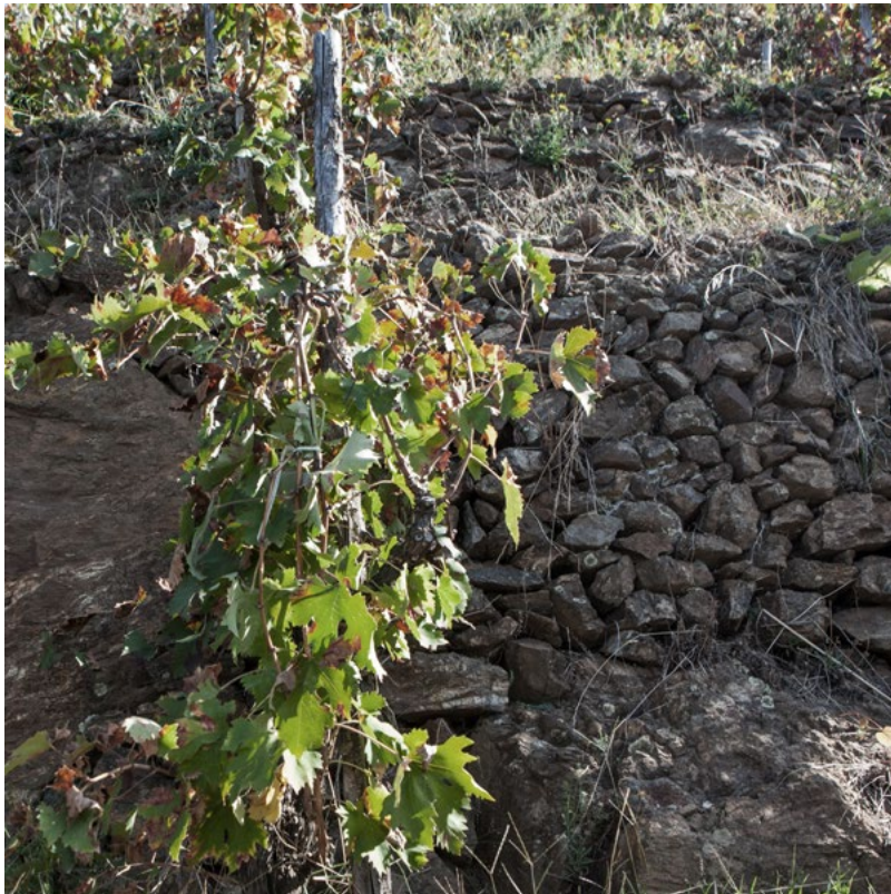
Figura 1. Dettaglio di un terrazzamento della Costa Viola (foto S. Mileto, 2013).
