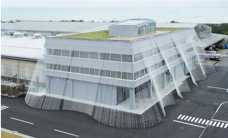
Figura 4. L'edificio della società Komatsu Seiren a Nomi, nella prefettura di Ishikawa, in Giappone, è la prima struttura di adeguamento sismico al mondo realizzata in fibra di carbonio ed è stata progettata dall'architetto giapponese Kengo Kuma, https://o.aolcdn.com/images/dims?quality=85&image_uri=http%3A%2F%2Fo.aolcdn.com%2Fhss%2Fstorage%2Fmidas%2Fba3ea58ffcebf92bc32db0113d45be1%2F203681121%2Fcabkoma-strand-rod.jpg&client=amp-blogs-v2&signature=58fae07d186b20f6743a2fd88abab18d3a824290 (ultimo accesso 12 febbraio 2019).
