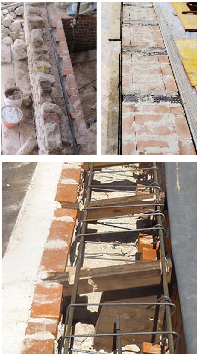
Figura 23 a-c. L'Aquila, cordolature sommitali in muratura armata (foto di S. Cecamore).
