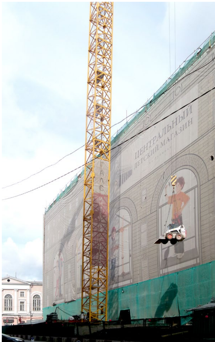
Figura 3. Mosca, ZTL accanto al Bol'shoj, ristrutturazione interna di edificio ottocentesco con mantenimento della facciata (foto S. Aragona, 2014).
