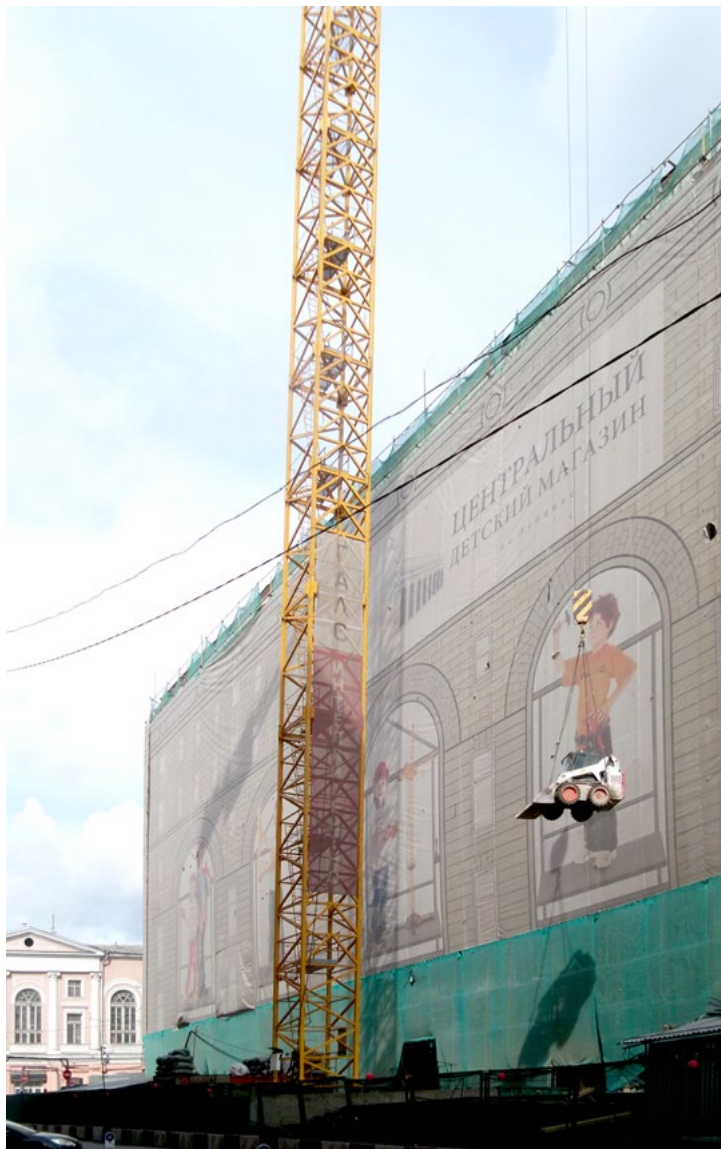
Figura 3. Mosca, ZTL accanto al Bol'shoj, ristrutturazione interna di edificio ottocentesco con mantenimento della facciata (foto S. Aragona, 2014).
