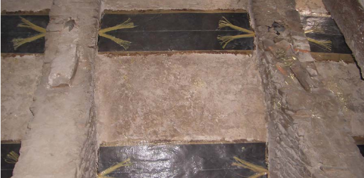
Figura 8. Minimo intervento di consolidamento con materiali compositi (fibre di carbonio e fibre di vetro in matrice resinosa) di una volta a padiglione nel Palazzo Comunale di Modena (progettisti proff. Angelo Di Tommaso e Carlo Blasi): l'intervento blocca il meccanismo di danno individuato senza ostacolare possibili adattamenti al mutare delle condizioni al contorno.
