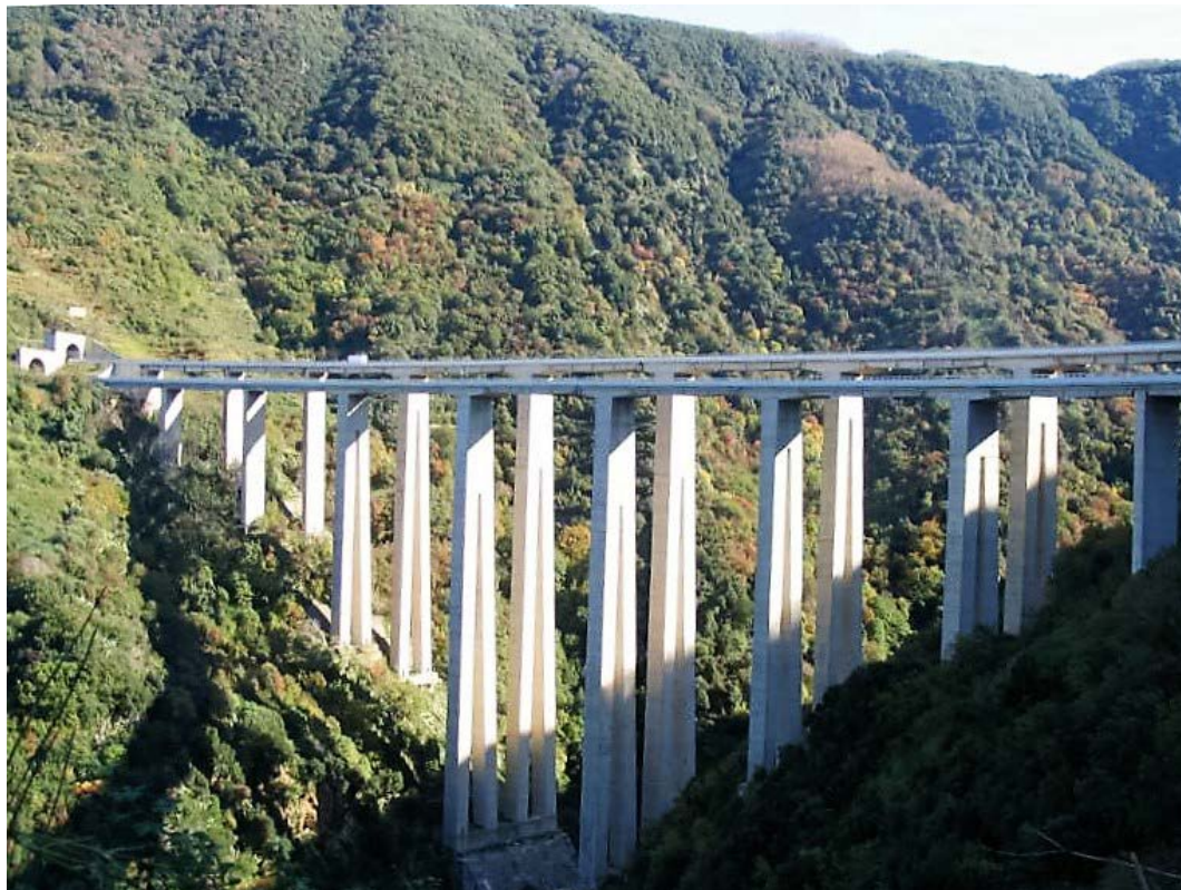
Figura 1. Il viadotto di Favazzina dell'autostrada Salerno-Reggio Calabria tra Scilla e Bagnara, demolito nel 2015 (da L. Arnese, Il viadotto di Favazzina , http://www.officinaitalia.it/drupal/?q=node/84 : ultimo accesso 5 settembre 2016).
