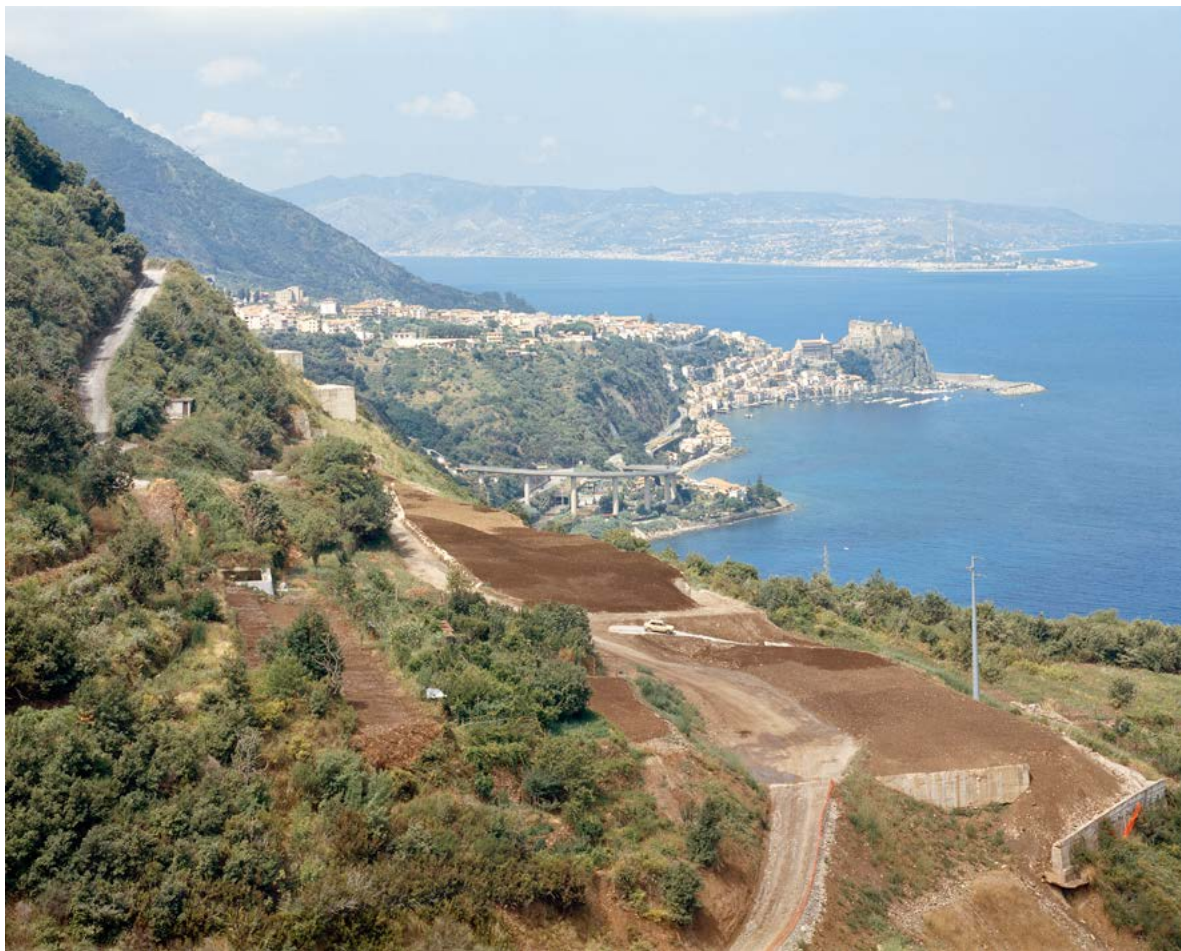
Figura 1. La costa tirrenica reggina sullo sfondo dello Stretto durante i lavori di ammodernamento dell'Autostrada Salerno - Reggio Calabria (foto di A. Perna, esposta nella mostra Verso il Mediterraneo. Sezioni del paesaggio da Salerno a Reggio Calabria, Roma, Istituto Centrale per la Grafica, 15 dicembre 2016 – 14 gennaio 2017. http://www.artnoise.it/ai1ec_event/verso-il-mediterraneo-sezioni-del-paesaggio-da-salerno-reggio-calabria/?instance_id=: ultimo accesso 25 ottobre 2017).
