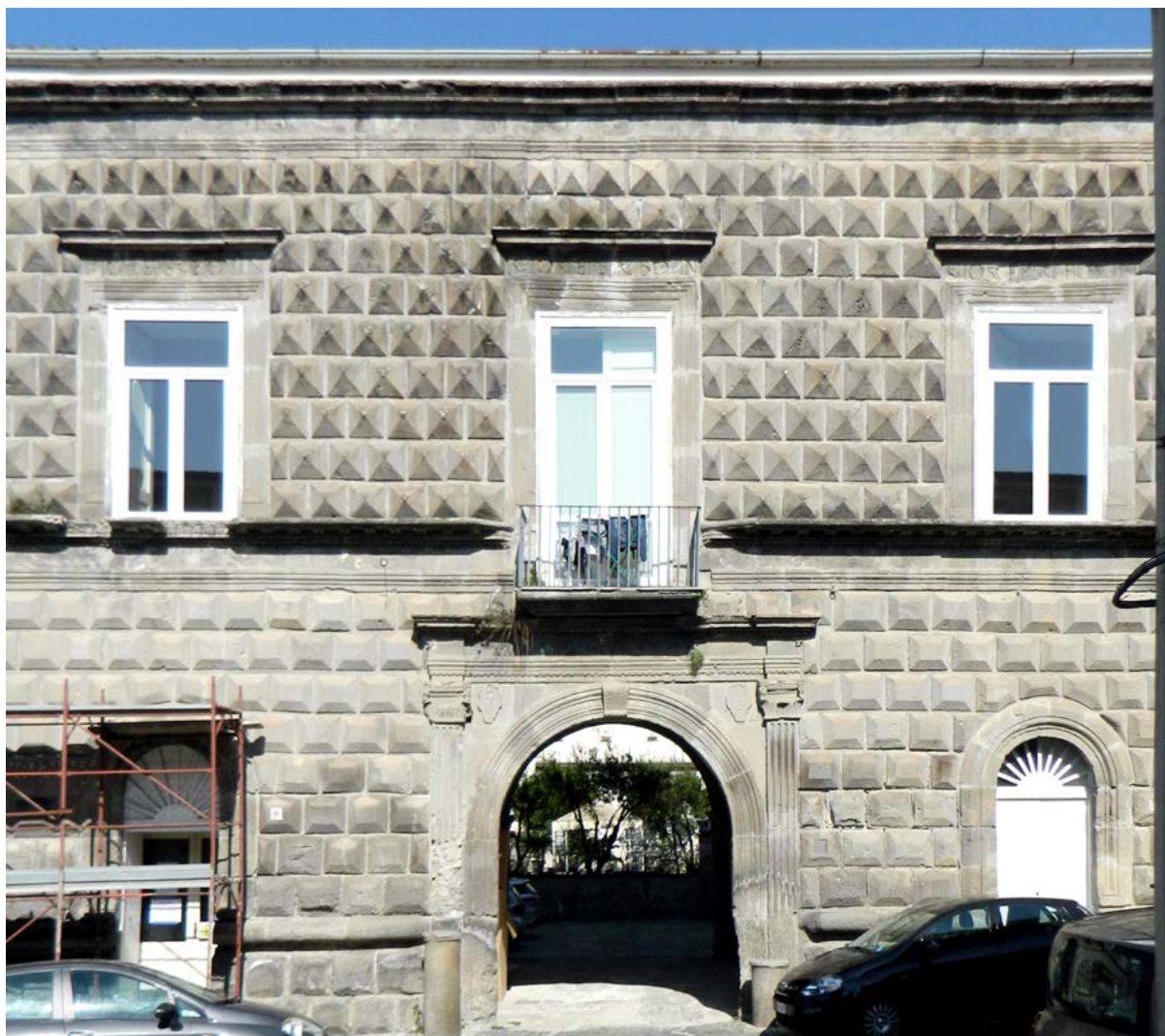
Figura 2. Lauro, palazzo dei Tufi, prospetto principale, particolare del bugnato (foto R. Serraglio, 2019).
