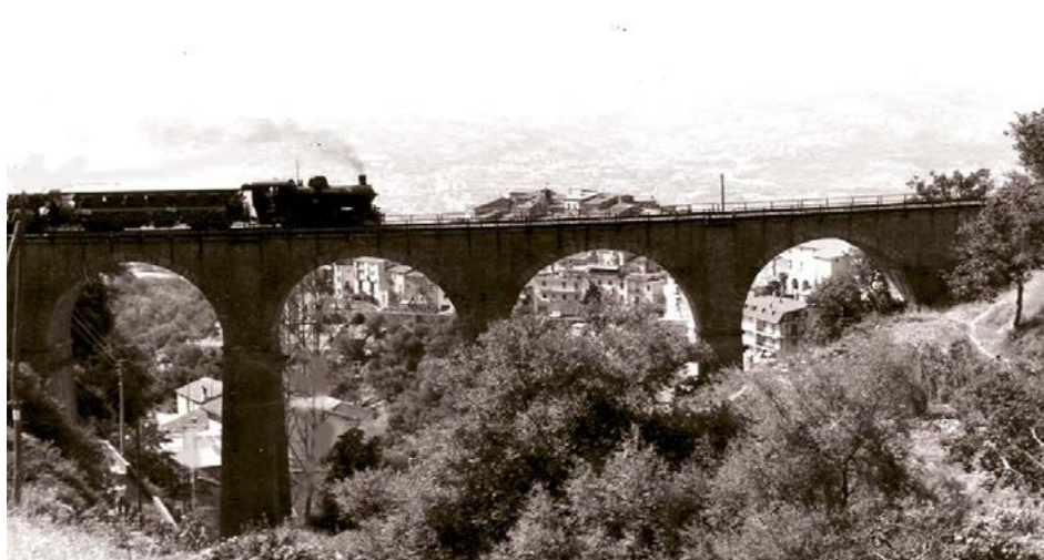
Figura 9. Linea delle Ferrovie Calabro Lucane (oggi Ferrovie della Calabria ) viadotto di San Pietro in Guarano (CS) (Collezione Iuliano, Pizzuti, http://www.linkingcalabria.it/wordpress/wp-content/uploads/2016/03/ferrovie-calabria.jpg : ultimo accesso 1 settembre 2017).
