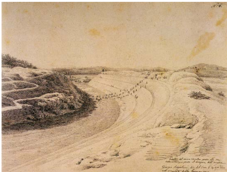
Figura 16. Giorgio Angiolini, « Veduta del nuovo canale presso alla sua imboccatura preso al di sopra dell'argine » (da BONELLI CONENNA, BRILLI, CANTELLI 2004). Angiolini, incaricato dal Granduca di documentare «dal vivo» l'andamento dei lavori di bonifica, eseguì il disegno il 24 aprile 1830, «al momento della lavorazione». Due anni prima era stato dato l'avvio dello scavo del canale «diversivo» ideato da Giuseppe Manetti per bonificare, «colmandola» con le acque limacciose delle piene dell'Ombrone, la palude di Castiglione della Pescaja.
