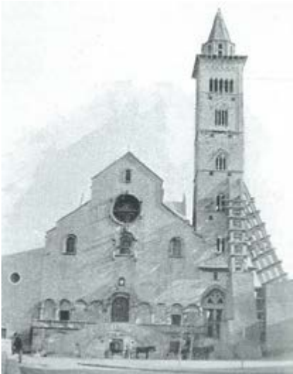
A sinistra, figura 52. Trani, Cattedrale in una fotografia del 1902 con i presidi lignei in corrispondenza del campanile (foto Soprintendenza BB. AA. e Paesaggio, Bari); in basso, figura 53. Trani, Cattedrale nel 1956 durante la ricostruzione del campanile (foto Soprintendenza BB. AA. e Paesaggio, Bari).
