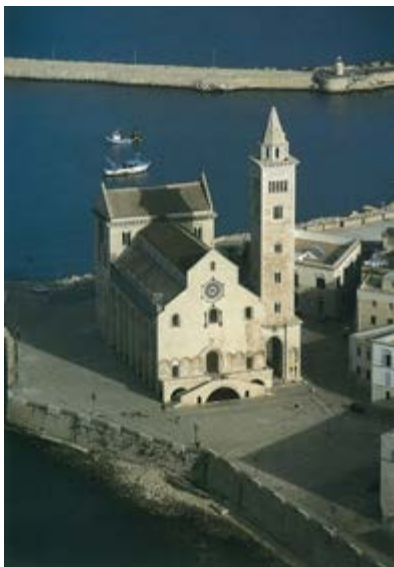
Dall'alto, in senso orario, figura 49. Trani, Cattedrale in una fotografia del 1911 (da una cartolina d'epoca); figura 50. Trani, Cattedrale, veduta aerea prima dei restauri del fronte nord (foto Soprintendenza BB. AA. e Paesaggio, Bari); figura 51. Trani, Cattedrale, veduta aerea attuale (foto Aerofototeca Nazionale).
