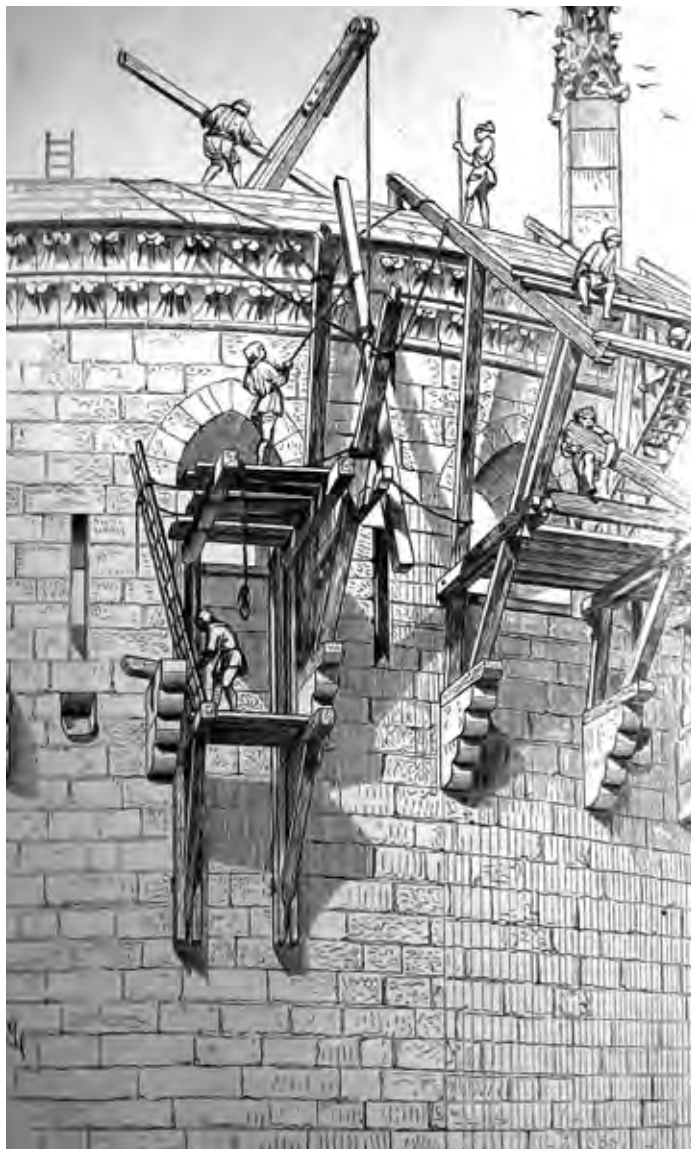
Figura 5. E.E. Viollet-le-Duc, Constructions des hourds du dojon (da E.E. VIOLLET-LE-DUC, Description du château de Coucy , Librairie Centrale d'art et d'architecture, Paris 1875, p. 24).
