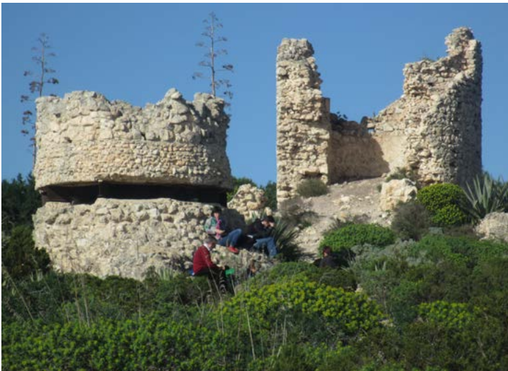
Figuras 19-20. Búnkeres resueltos con formas camaleónicas en Cerdeña: arriba, figura 19, Búnker que asemeja un depósito de agua (Molentargius, Cagliari); abajo, figura 20, búnker que asemeja una torre histórica hecha con los materiales de la adyacente (Cagliari), (fotos A. Pirinu, 2018).
