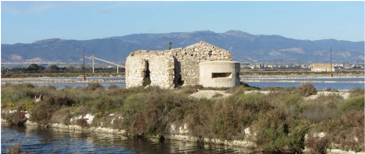
Figuras 21-23. Búnkeres resueltos con formas camaleónicas en Cerdeña: arriba a la izquierda, figura 21, búnker que asemeja una ermita rural: los ladrillos están pintados (Quartu Sant' Elena); arriba a la derecha, figura 22, búnker camuflado como una roca con vegetación (Quartu Sant' Elena); abajo, figura 23, búnker camuflado como una caseta rural (Saline - Molentargius, Cagliari), (fotos A. Pirinu, 2018).
