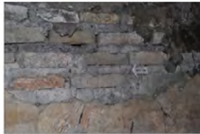
11E.17_02 - dettaglio prima del prelievo
