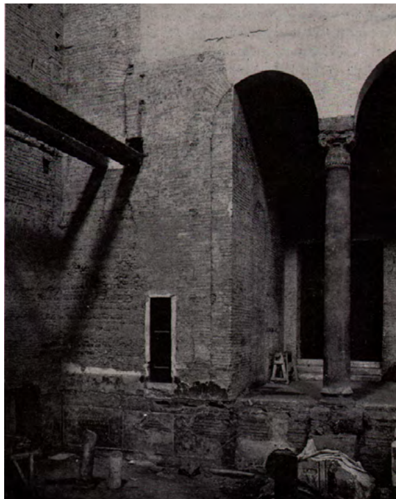
Da sinistra, in senso orario, figure 4-6. Le prime tracce dell'aula absidata, la controfacciata della chiesa e l'angolo nord-ovest della navata centrale durante i lavori condotti dall'Associazione Artistica fra i Cultori di Architettura nel 1900-1910 (da CANNIZZARO 1902; KRAUTHEIMER, CORBETT, FRANKL 1976).
