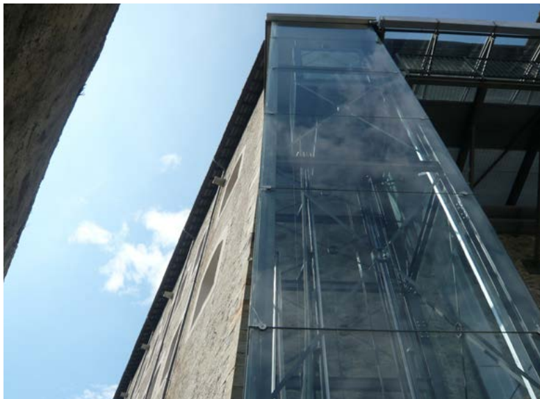
Figura 4. Forte di Bard (AO). L'ascensore verticale che porta in sommità della fortezza (foto A. Arengi).
