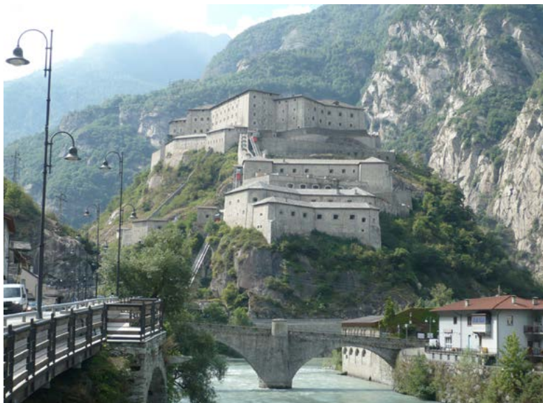
Figura 3. Forte di Bard (AO). Vista complessiva da nord con i tre ascensori inclinati (foto A. Arengi).
