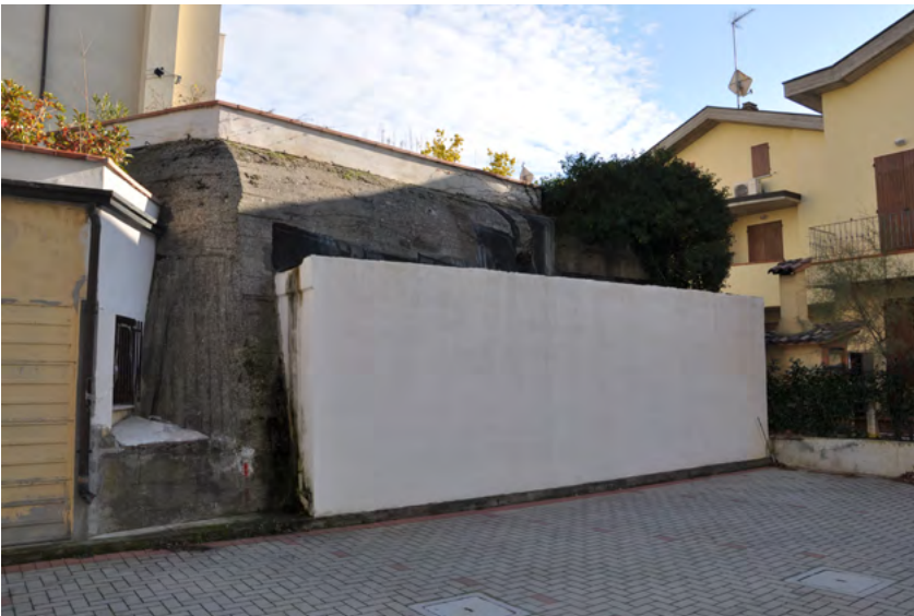
Figura 20. Lido di Savio (RA), bunker a servizio di una struttura alberghiera riadattato per ospitare camere da letto (foto A. Zampini, 2018).
