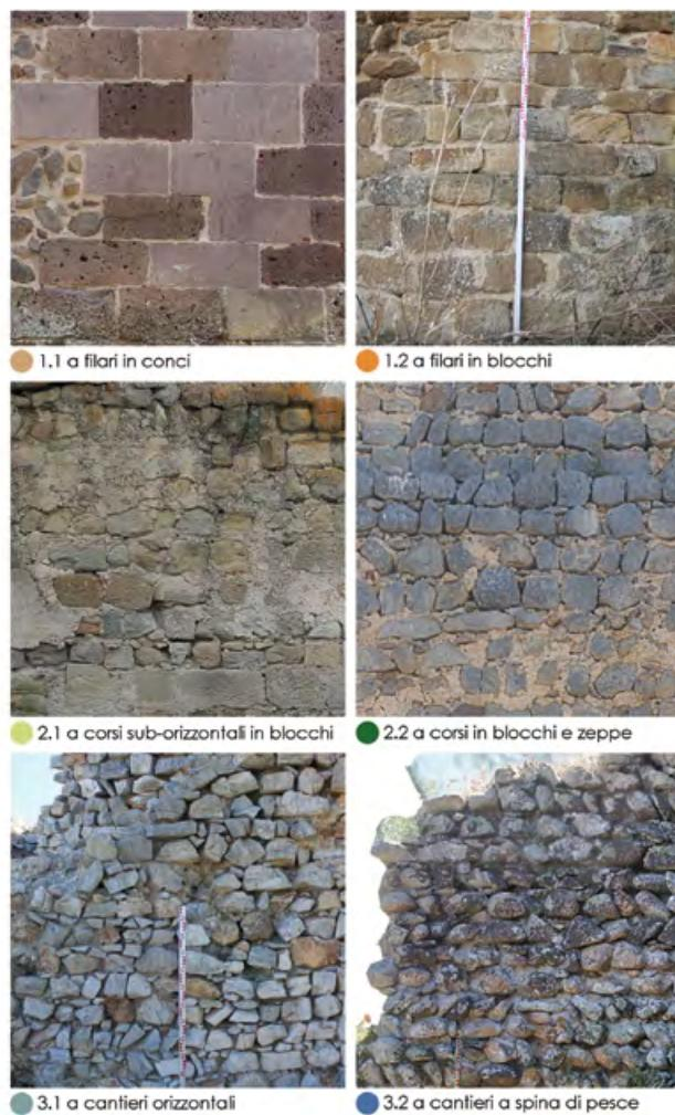
Figure 12a-b. La distribuzione dei tipi murari individuati nell'areale, con l'indicazione, per ogni caso studio, delle varianti (a). Quadro sinottico delle sei tipologie murarie classificate in base all'apparecchiatura muraria e alla forma prevalente del materiale lapideo (b) (elaborazione V. Pintus).
