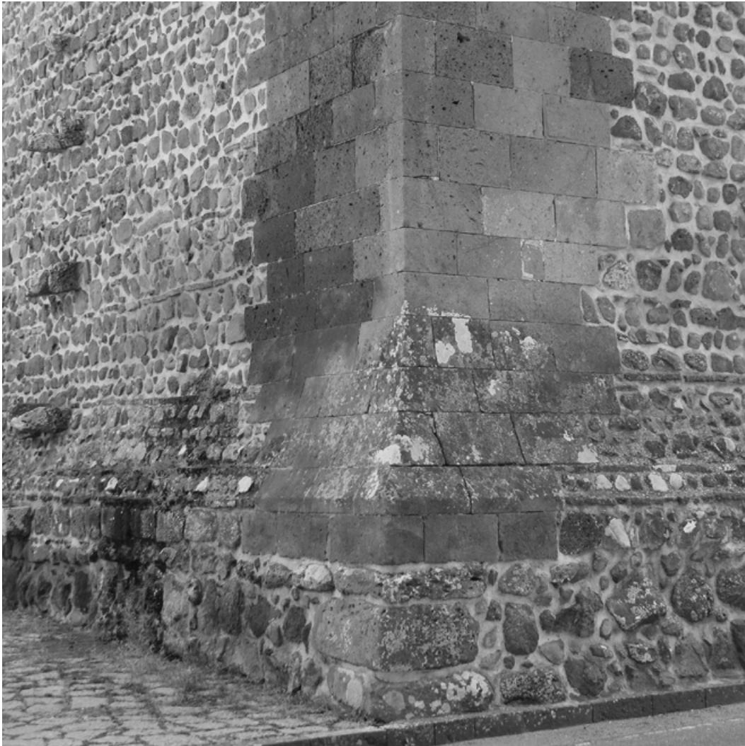
Figura 11. Ghilarza, Donjon. La fabbrica è realizzata prevalentemente con un unico litotipo, il basalto, impiegato in forme diverse: lavorato (conci squadrati), semilavorato (bozze) e non lavorato (grossi trovanti impiegati nel basamento) (foto V. Pintus 2015).
