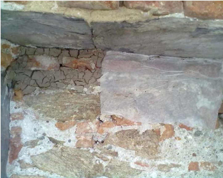
Figure 18-19. Savona, santuario di Nostra Signora della Misericordia, fronte principale dell'Ospizio dei poveri. Sopra, sottili lastre in ardesia impiegate come sagome “a perdere” nel cornicione; sotto, lastre più spesse a sostegno della cornice sommitale (foto S. Musso, 2012).
