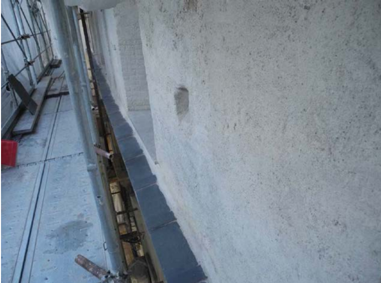
Figura 27. Savona, santuario di Nostra Signora della Misericordia, fronte principale dell'Ospizio dei poveri. Particolare della nuova copertina in ardesia a protezione delle cornici marcapiano (foto S.F. Musso, 2012).
