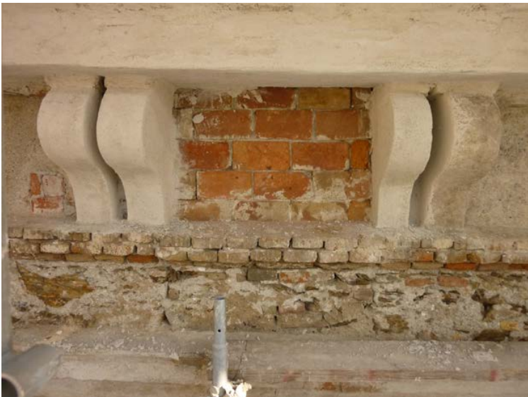
Figura 14. Savona, santuario di Nostra Signora della Misericordia, fronte principale dell'Ospizio dei poveri. Particolare della cornice in mattoni pieni che taglia un'apertura successivamente tamponata (foto S.F. Musso, 2012).
