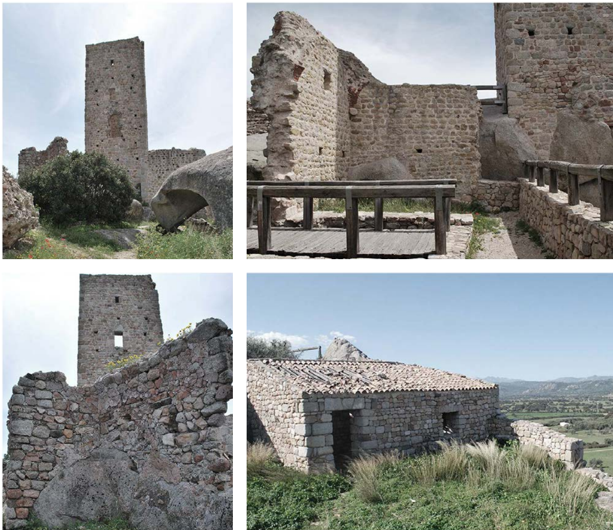
Figura 11. Olbia (SS), il castello di Pedres. Da sinistra, in senso orario: il mastio; l'aula; cisterna; struttura anti-aerea (foto M.S. Pirisino, 2016).
