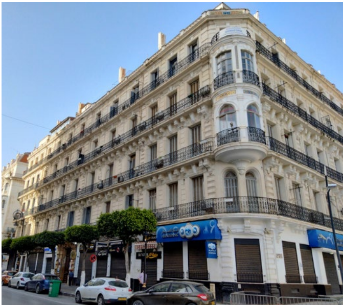
Figures 11-12. Alger Centre, exemples d'immeubles d'appartements du 19 ème siècle. En haut: 3 rue Ali Boumendjel. En bas: 37 rue Larbi Ben M'hidi (photo A. Oukaci, 2024).
