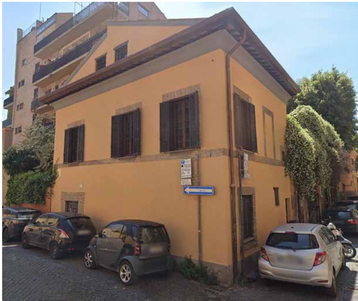
Figura 11. Unità edilizia posta all'angolo NO dell'aggregato UU-A 7, tra la via e il vicolo della Penitenza. L'edificio residenziale è riconducibile alle tipologie seriali del XVII-XVIII sec. Tuttavia, si rilevano interventi quali la tamponatura del vano finestra, l'apertura di nuove bucatore e il rifacimento della copertura. Tali evidenze concorrono alla formazione del sotto-indice relativo alle cosiddette "riparazioni moderne" (foto A. Martello, 2023).
