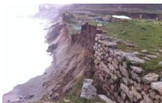
Fig.3 - Muro esterno del tempio dorico dopo le mareggiate di dicembre 2013 (sx) e di febbraio 2014 (dx).
