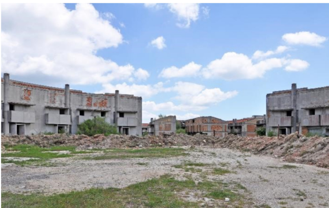
Fig. 4 - Lo spazio interno del quartiere prima della demolizione. (fonte: archivio degli autori, 2017)
