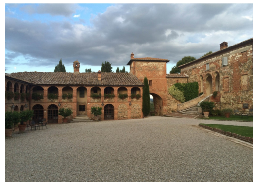
Fig. 4 - Fattoria l'Amorosa, veduta del cortile interno con l'accesso principale. (fonte: foto dell'autrice)
