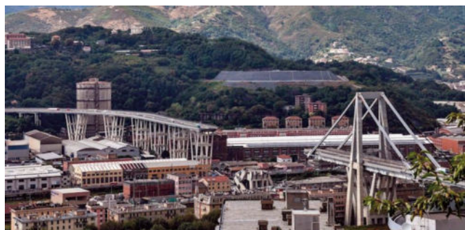
Fig. 2 - Genova, Ponte Morandi tra crollo ed edifici (fonte: PIERO CRUCIATTI/AFP/Getty Images, 2018 https://www.ipost.it/2018/08/15/ponte-morandi-crollo-cause-responsabili/ )
