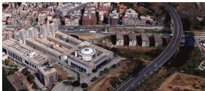
Fig. 6 - I quattro scheletri della Casa dello studente accanto all'area di espansione dell'Annunziata intubata
