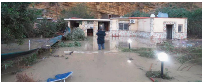
Fig. 5 - Villino abusivo luogo di tragedia (Fonte: ilfattoquotidiano , 2018)
