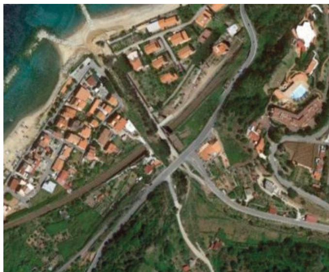
Fig. 1a - Inquadramento del ponte sito in Villa San Giovanni (fonte: propria elaborazione)
