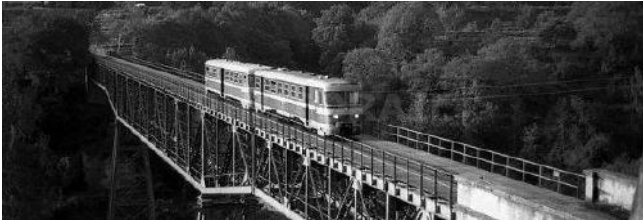
Fig.2 – Ponte di Sant'Eufemia (fonte Ferrovie della Calabria)
