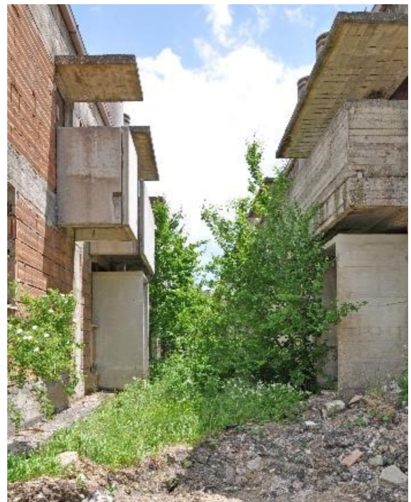
Fig. 6 - La strada interna alla doppia cortina prima della demolizione. (fonte: archivio degli autori, 2017)
