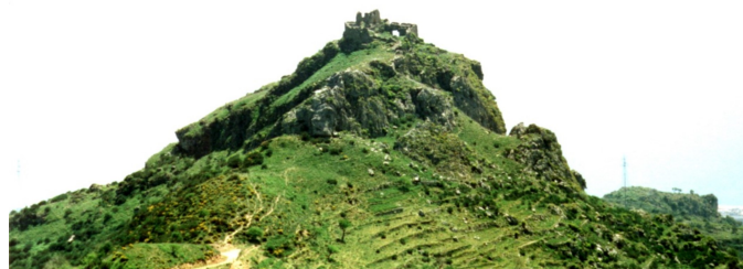
Fig. 10 - Il Castello Belvedere visto da nord-ovest. (fonte: propria elaborazione)
