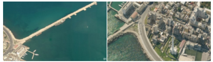
Fig. 6 - Stato attuale del molo di San Cataldo. (fonte: propria elaborazione)
