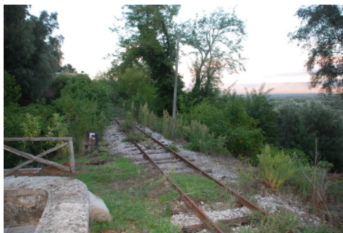
Fig.3 - Linea abbandonata delle Ferrovie della Calabria, Comune di Melicuccà - RC Fonte: di D. Campolo
