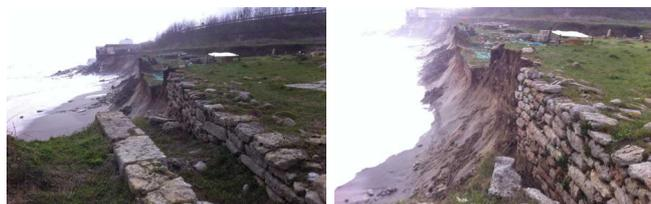
Fig.3 - Muro esterno del tempio dorico dopo le mareggiate di dicembre 2013 (sx) e di febbraio 2014 (dx).
